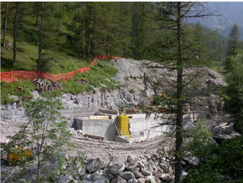
Opera di presa
