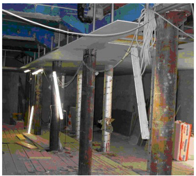
Particolari strutture provvisorie di sostegno fabbricato sovrastante
