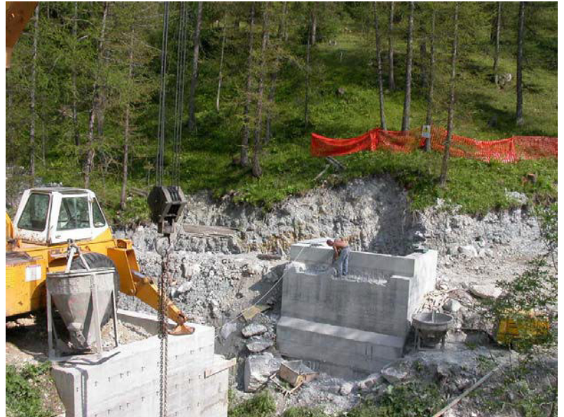
Passerella accesso opera di presa
