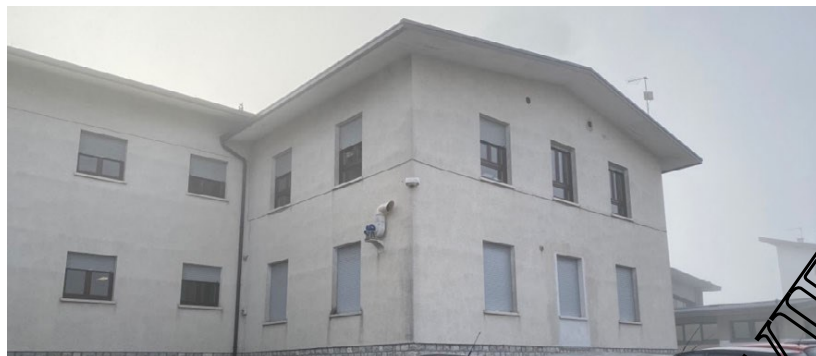
Figura 2 Vista esterna del corpo originale del 1959 dal parcheggio sul retro
