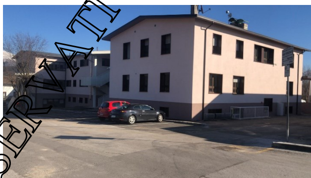
Figura 39 Lavori conclusi – prospetto Nord-Ovest
