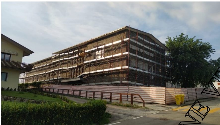
Figura 35 Avanzamento posa Geniale Cappotto Sismico – prospetto Nord-Est
