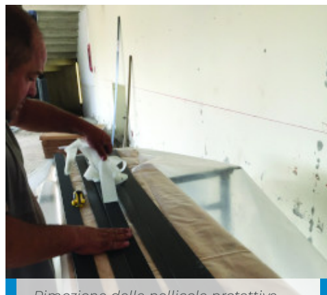
Rimozione delle pellicole protettive dalla lamina Carboplate W
