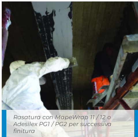
Applicazione di MapeWrap 11 / 12 o Adesilex PG1 / PG2 sulla lamina Carboplate W
