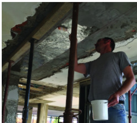
Applicazione di MapeWrap Primer 1
