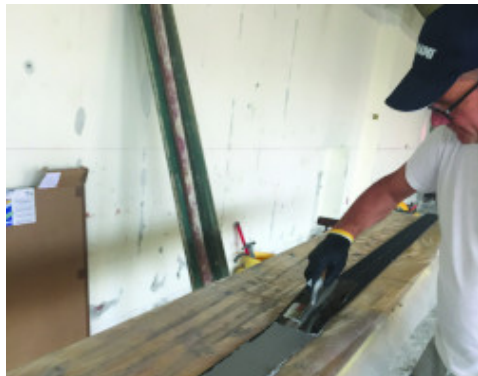
Applicazione di MapeWrap 11 / 12 o Adesilex PG1 / PG2 sulla lamina Carboplate W
