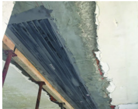
Trave rinforzata con Carboplate W System
