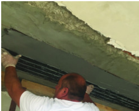
Applicazione della lamina Carboplate W
