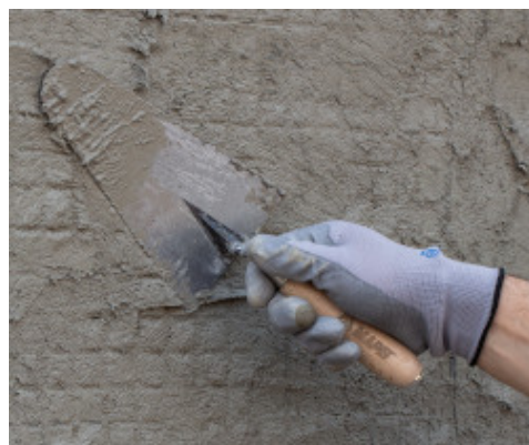
Applicazione del secondo strato di malta Planitop HDM Maxi
