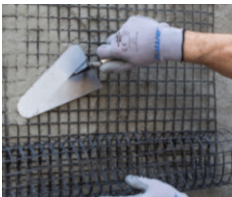
Applicazione della rete Mapegrid G 220
