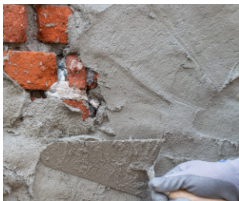
Applicazione del primo strato di malta Planitop HDM Maxi
