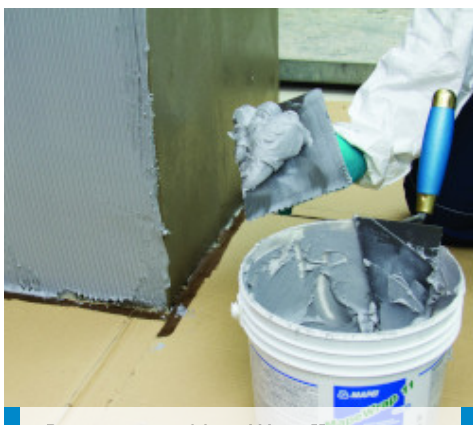
Rasatura con MapeWrap 11 o MapeWrap 12
