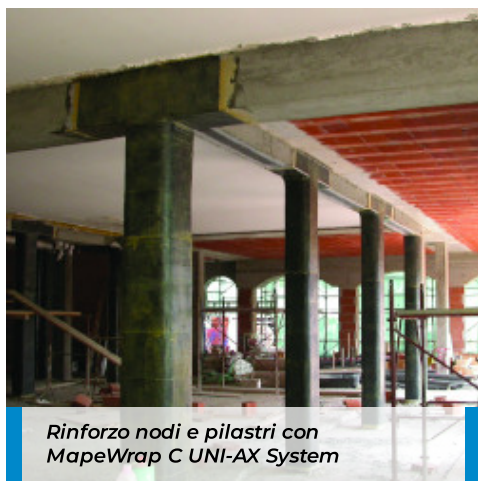
Applicazione del tessuto MapeWrap C UNI-AX impregnato con MapeWrap 31
