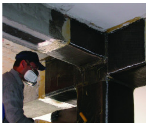
Confinamento nodo trave-pilastro con MapeWrap C UNI-AX System
