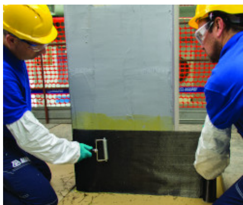
Applicazione del tessuto MapeWrap C UNI-AX impregnato con MapeWrap 31
